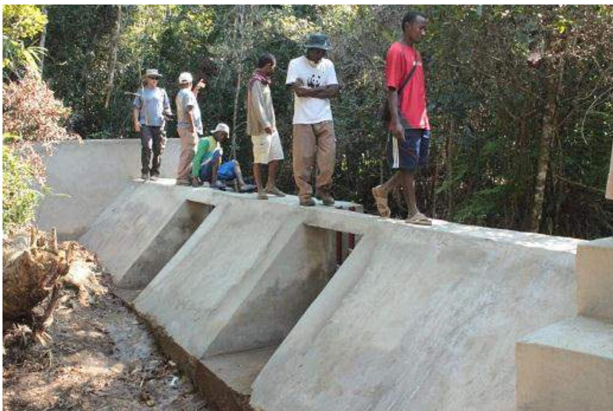
Photo66: Barrage d'irrigation à Ambatovita – Ivohibe (© PHCF)
