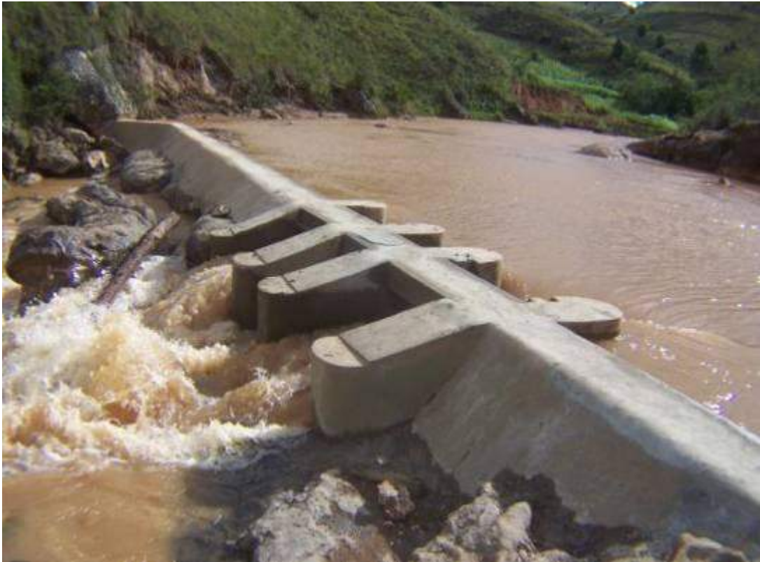
Photo 55: le barrage de Befasika (© PHCF)
